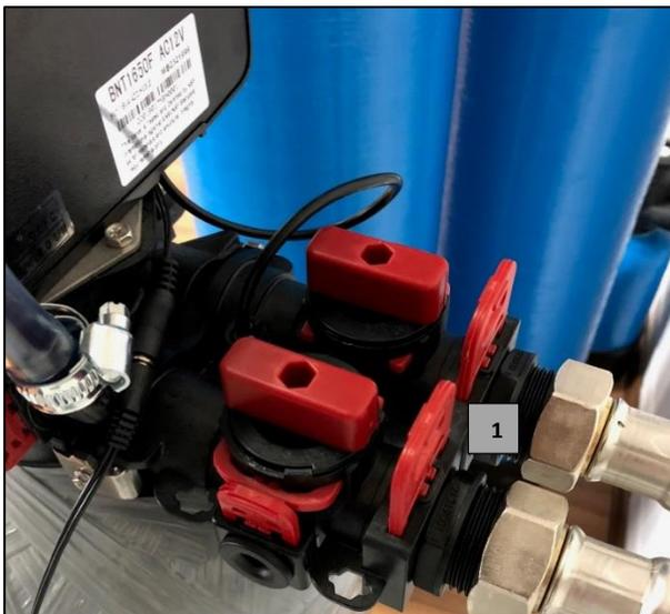
1. Steuerkopf mit Anschlussstück und Anschlussschläuchen.
